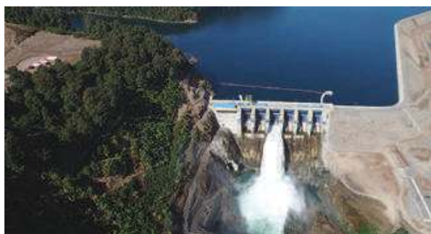
Central hidroeléctrica Angostura
